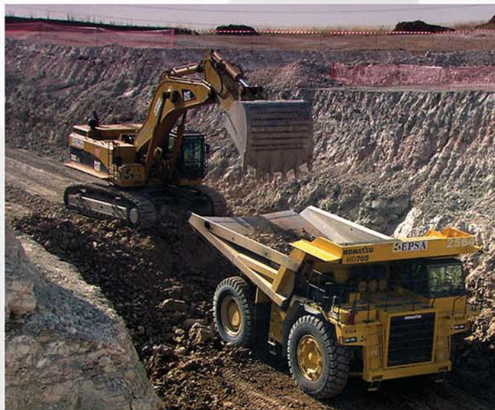
Retroexcavadora y dumper
