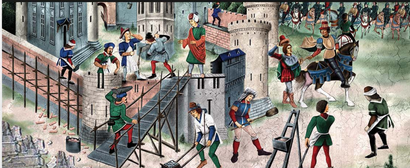
Maestro dirigiendo una obra en plena ejecución
