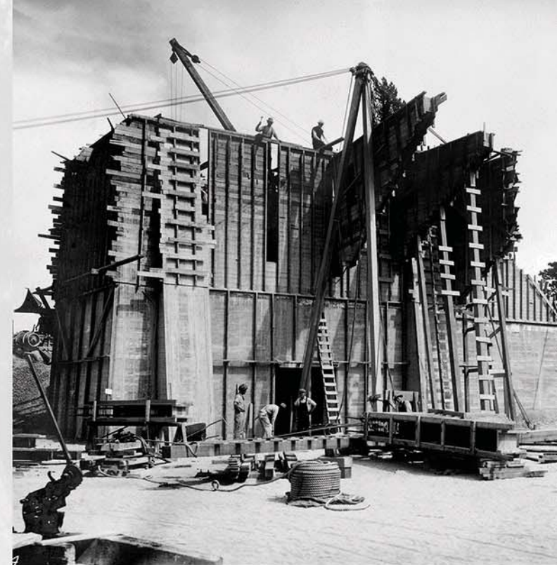
Encofrado tradicional artesanal de madera Observatorio Monte Wilson, 1918
