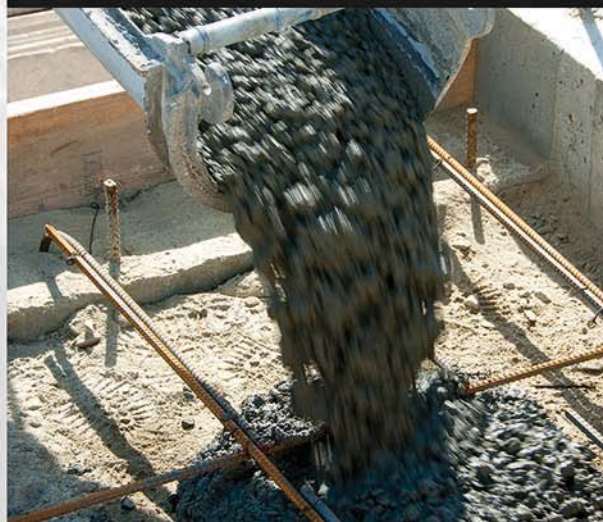
Vertido de hormigón sobre armadura (H.A.)
