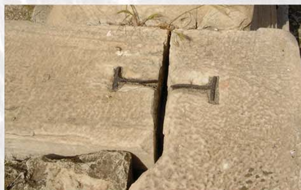
Vestigio de unión de sillares con grapa metálica doble T
