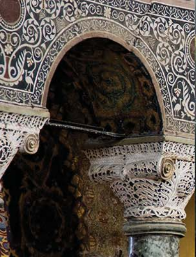
Tirantes en arquería de la Basílica de Sta Sofía. Constantinopla
