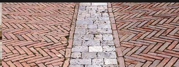
Ladrillos de canto y en espiga
