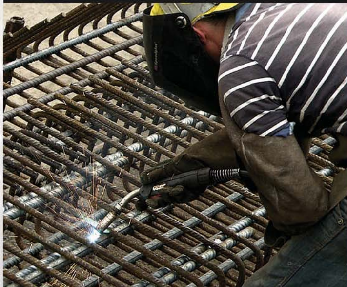
Fijación del armado mediante soldadura manual
