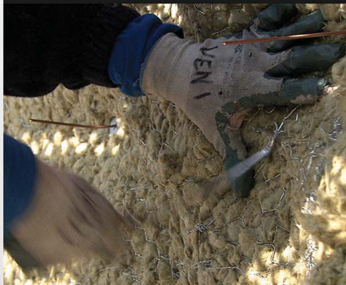
Colocación de aislamiento térmico
