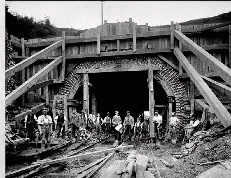
Encofrado tradicional de madera elaborado in situ Obra de ingeniería
