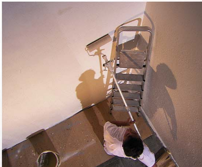
Imprimación del paramento
