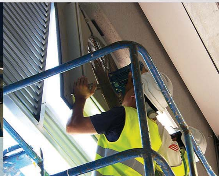
Instalación de climatización
