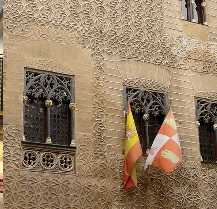
Estuco esgrafiado Fachada del Palacio de Cascales, Segovia, finales s.XV d.C.
