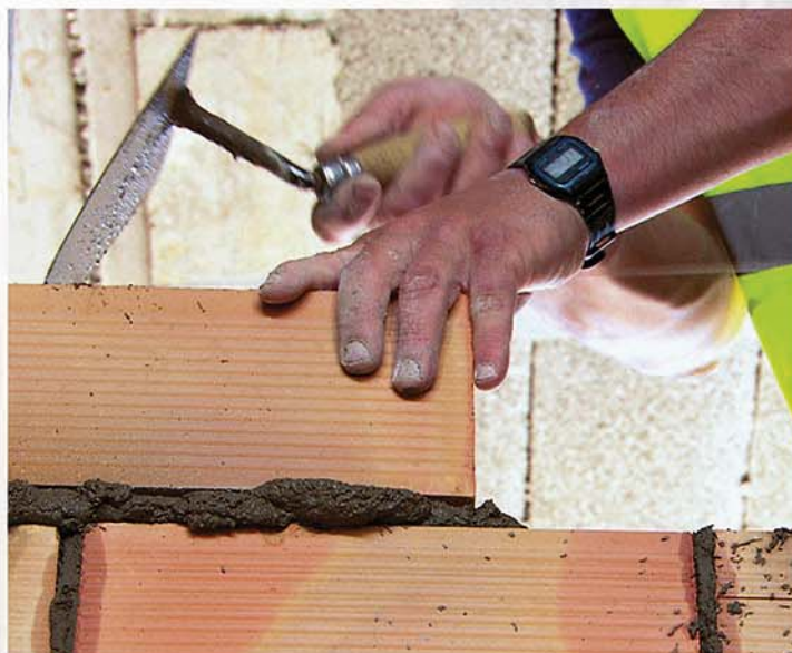
Ejecución de obra de ladrillo
