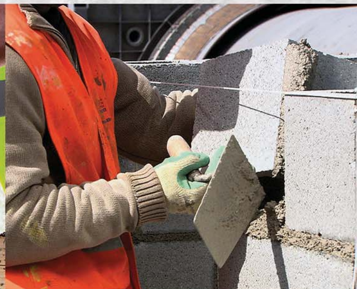
Recibido de bloque de hormigón
