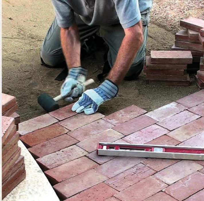
Ejecución de solado de ladrillo
