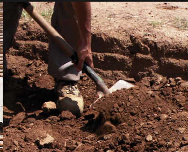
Realización de zanja horizontal de saneamiento
